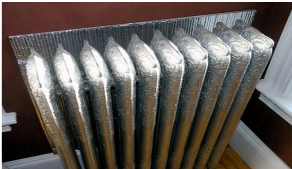
Рисунок. Пример установки теплоотражающего экрана
