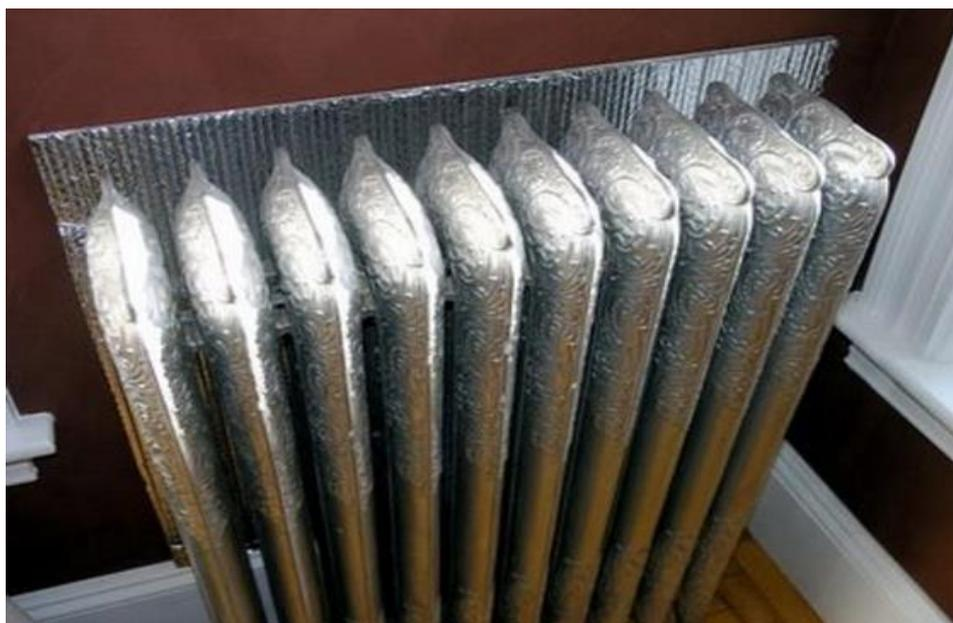
Рисунок. Пример установки теплоотражающего экрана
