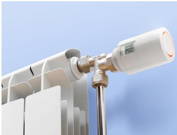
Рисунок. Радиаторный терморегулятор
